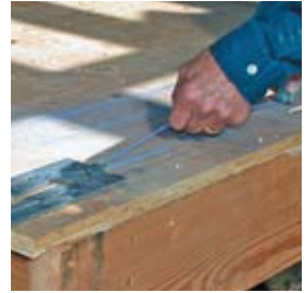
Hold chalk lines Sostener líneas marcadoras
