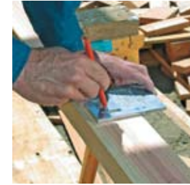
Mark stud locations Marcar las ubicaciones de las vigas
